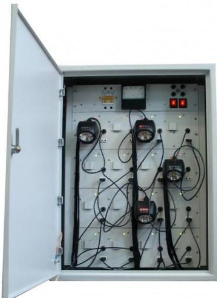
Станция СТАРТ М предназначена для автоматического заряда литий-ионных (Li-Ion) аккумуляторных батарей с номинальным напряжением 3,6 В в составе шахтных головных светильников СГГ-10 и метанометров СПУТНИК.
